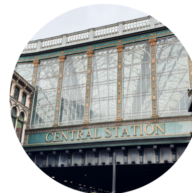
Exempel på skylt integrerad i fasad
