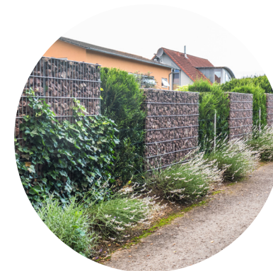
Exempel på inbägning med grön beklädnad, i detta fall gabionmur med klättrande växtlighet samt plantering framför.
