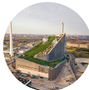
Amager Bakke, skidanläggning på tak.
