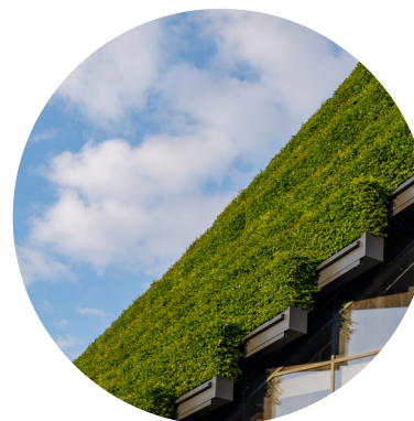
Detalj av fasad med växtvägg
