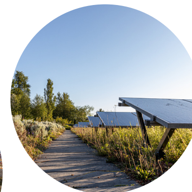
Kombinerat grönt tak med solceller
