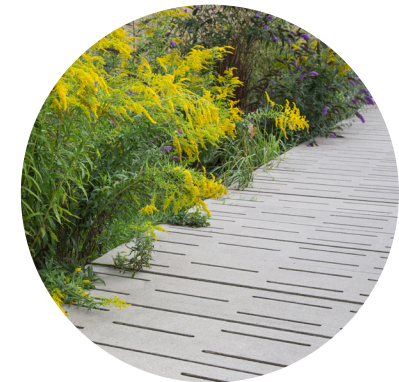
Gångbana med infiltrationsspår.
