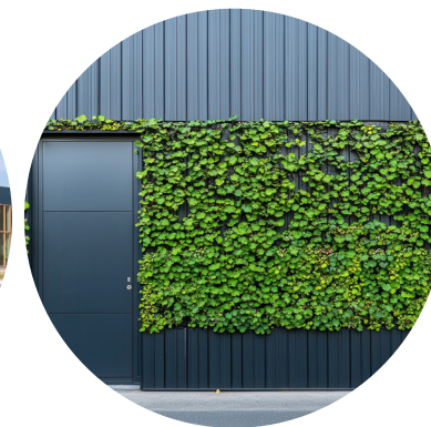
Grön växtvägg på industribyggnad.
