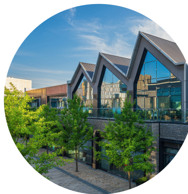
Gatufasad med dynamisk takform och materialelement
