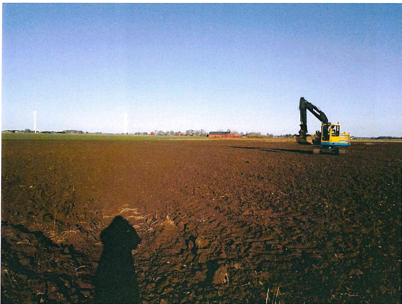
Fig 3. Vy över det platta landskapet. Foto mot norr.
